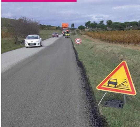
► Des travaux d'entretien ont été menés cet automne entre Montredon-des-Corbières et Montsérét avec un reprofilage de la RD 613 : les défauts de la chaussée ont été gommés et un enduit fibré a été mis en œuvre pour limiter la remontée des fissures et améliorer la résistance de cette route à l'usure du temps. Le tout pour un coût total de 467 000 €. Un vrai plus pour les usagers de cet axe !
